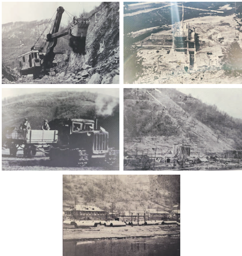
1–5. illusztráció Talabor–Nagy-ági vízerőmű építése.
